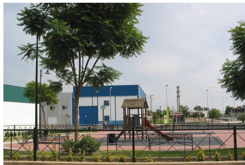
Vista de la fachada Noreste
