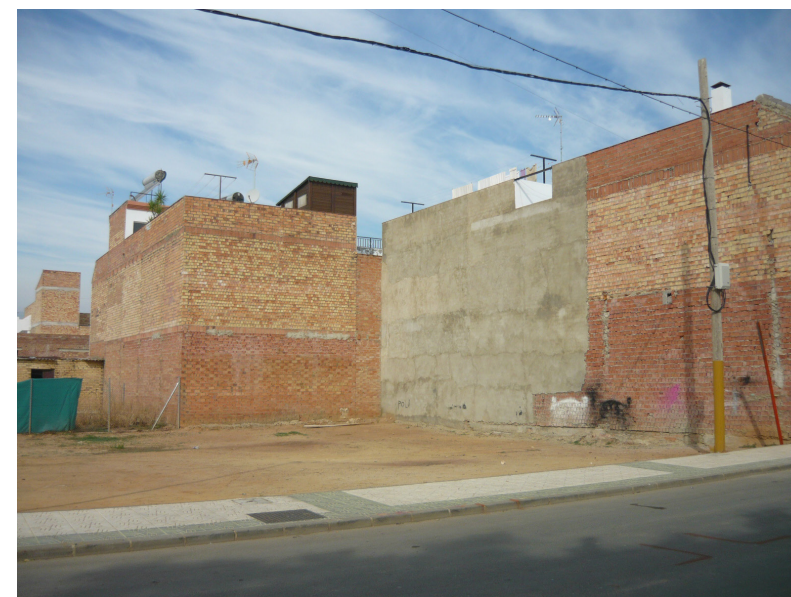
Estado de la edificación y del suelo
