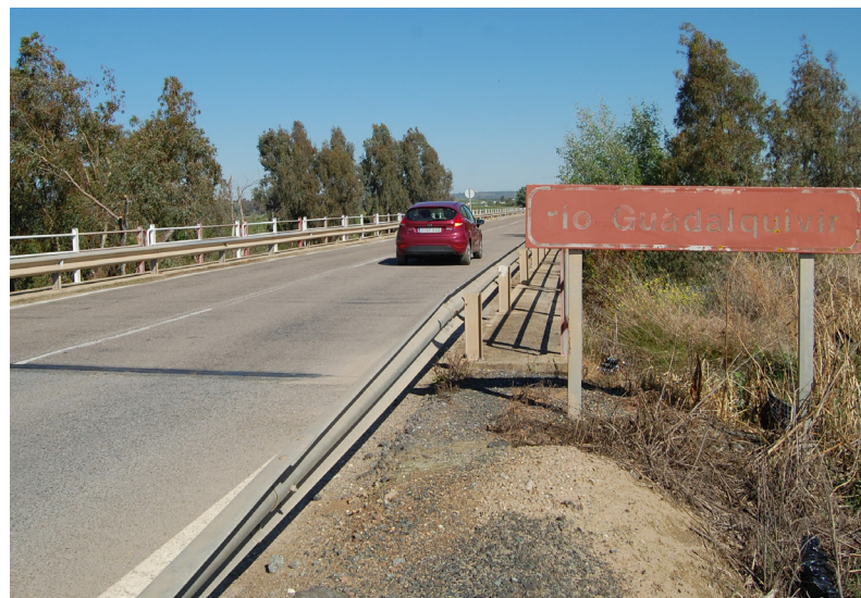
Puente sobre el Guadalquivir de la SE-4104.
