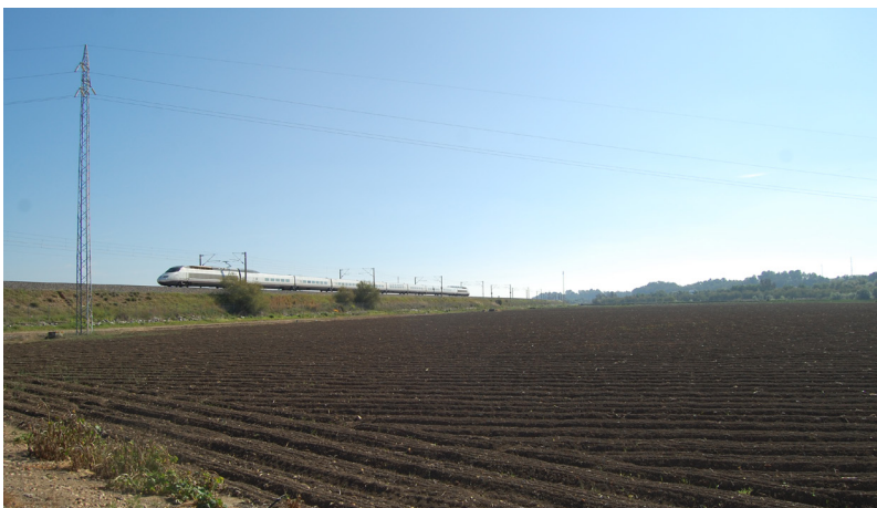
Línea férrea a su paso por Alcolea del Río sobre la SE-4104.
