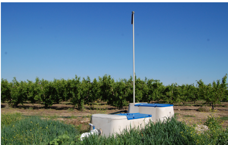
En las zonas de regadío del sur municipal, cada parcela dispone de una boca de riego con un contador que funciona a partir de una placa solar. El agua viene a través de tuberías subterráneas desde el bombeo principal que se abastece del Sistema Acuífero Aluvial del Guadalquivir.
