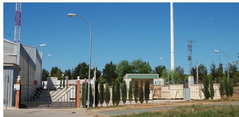
Punto limpio municipal situado en el Polígono Industrial Canama.
